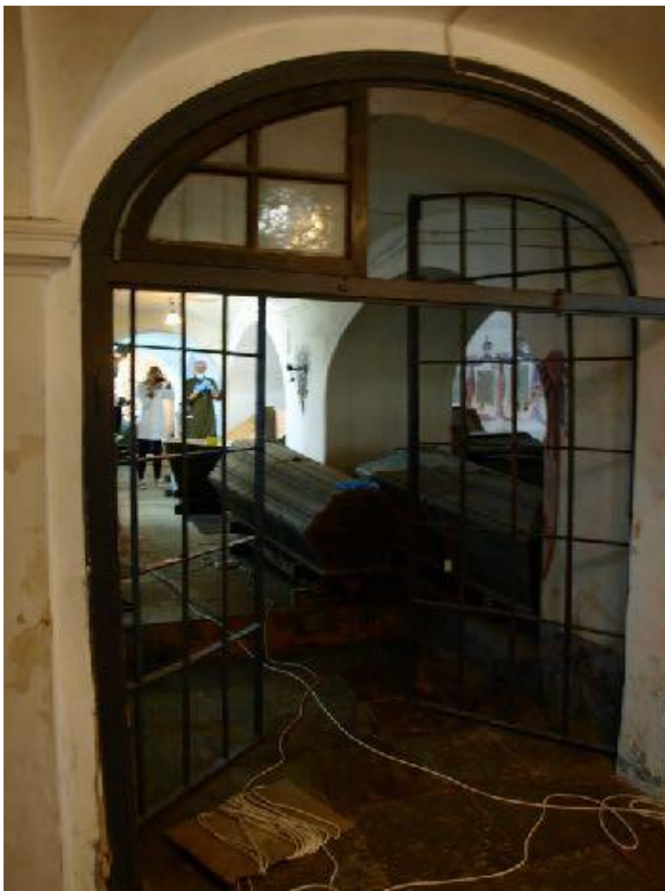
Pav. 1. Tyrimų metu rastas išlikęs autentiškas lango rėmas su stiklu.
