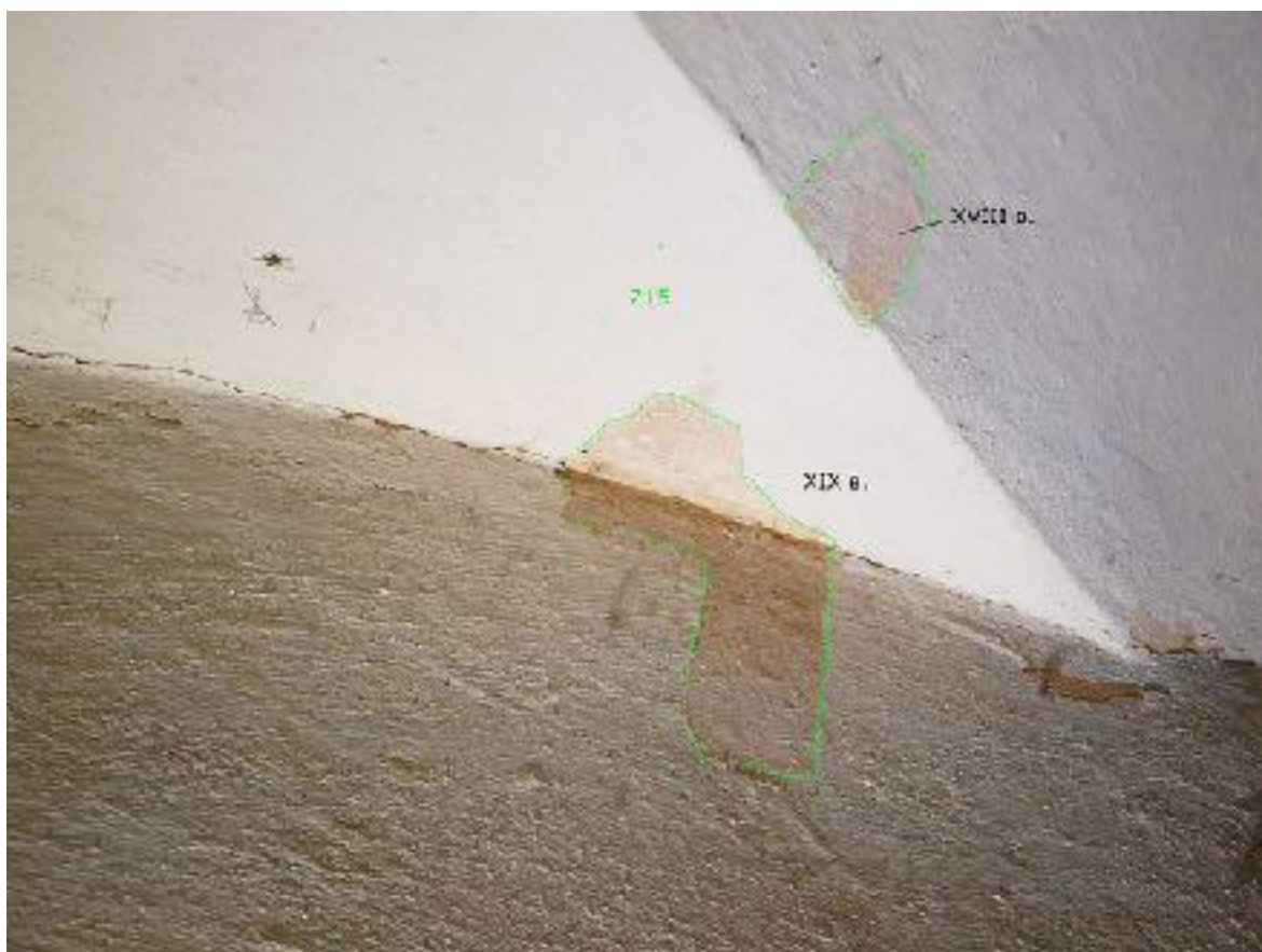
Pav. 24. 4 patalpa skliauto kampas. Polichromijos zondas Z15
