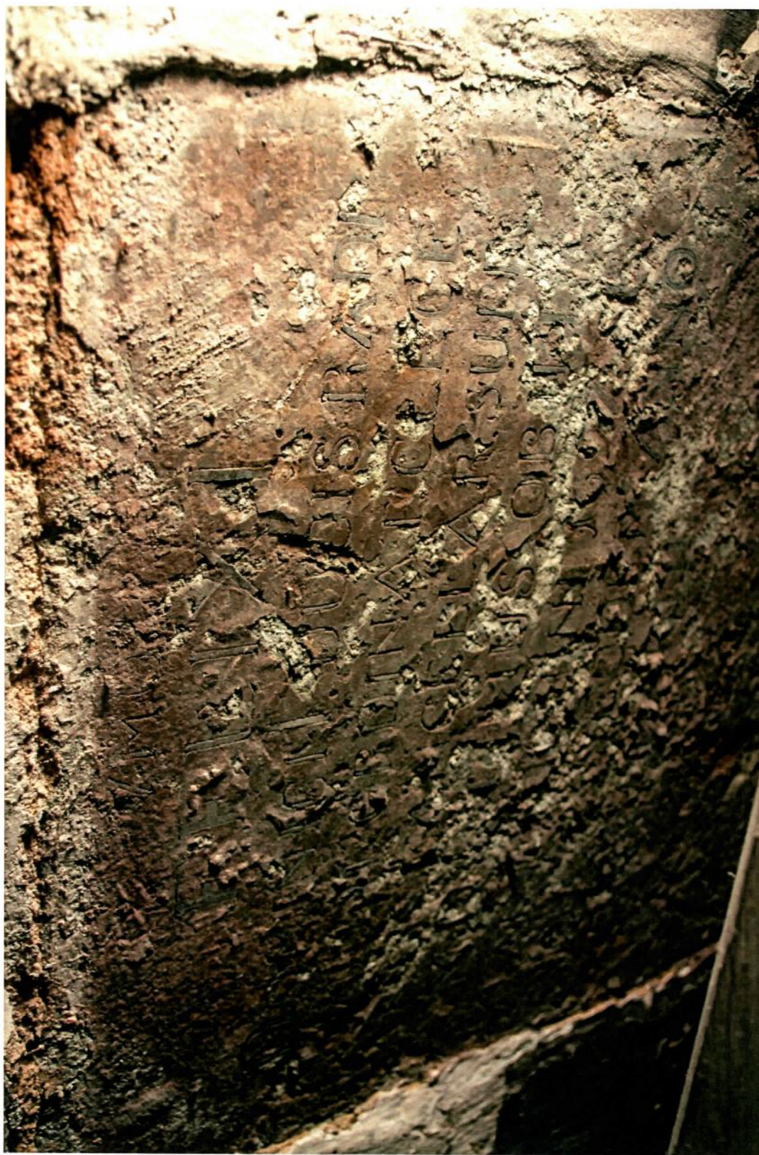
Расслоение надгробных плит.
