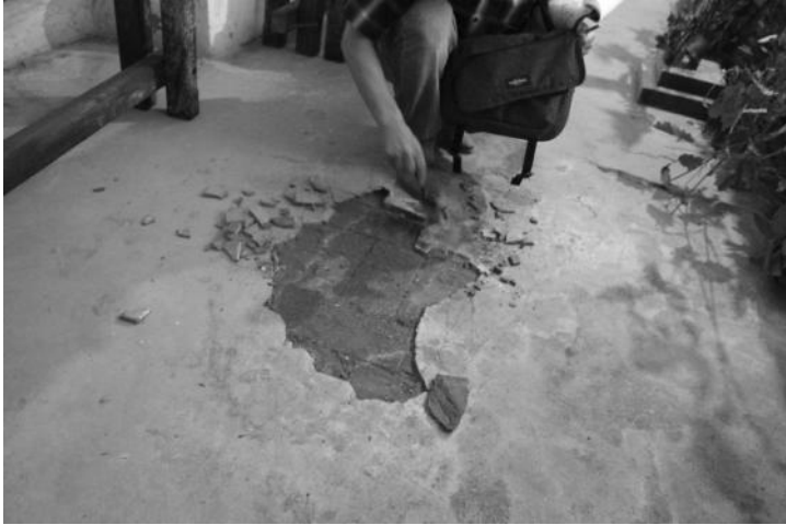
Бетонная сцяжка на цаглянай падлозе крытты.
